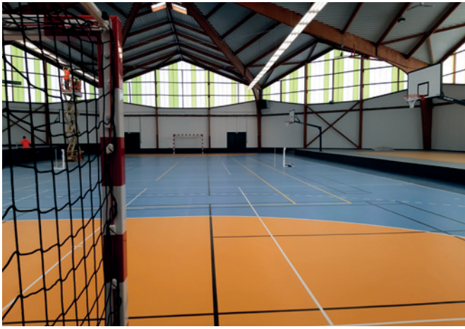
Gymnase Perrot - Achèvement des travaux
